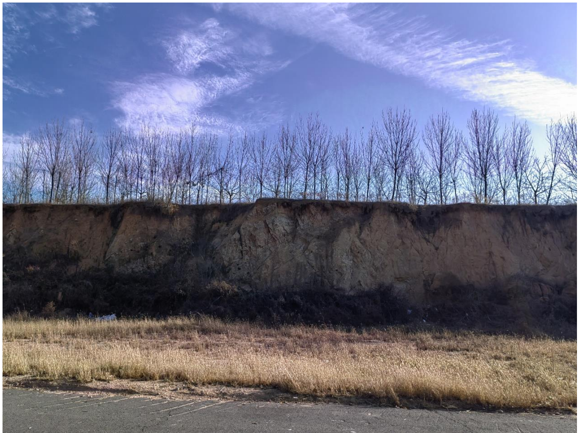
照片 2-9 宁海大道南侧边坡开挖
