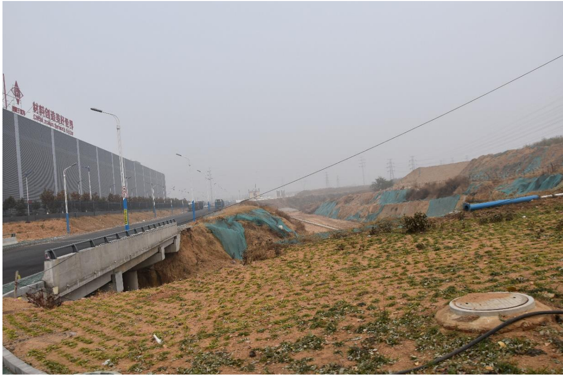
照片 2-10 开发区东区渤海乡梅庄村河道治理
