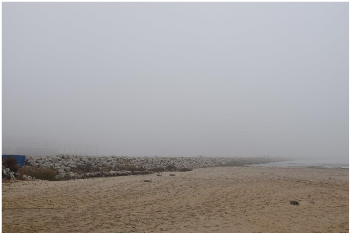
照片 3-2 开发区东区南部海滩防护
