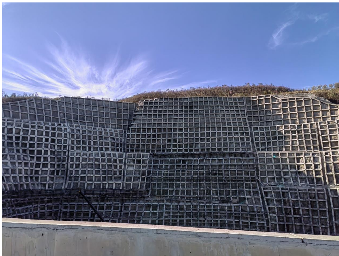
照片 3-1 开发区西区栖云山工程项目坡面治理
