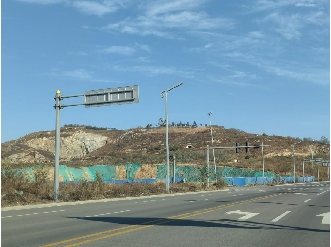
照片 2-8 开发区西区栖云山建设项目
