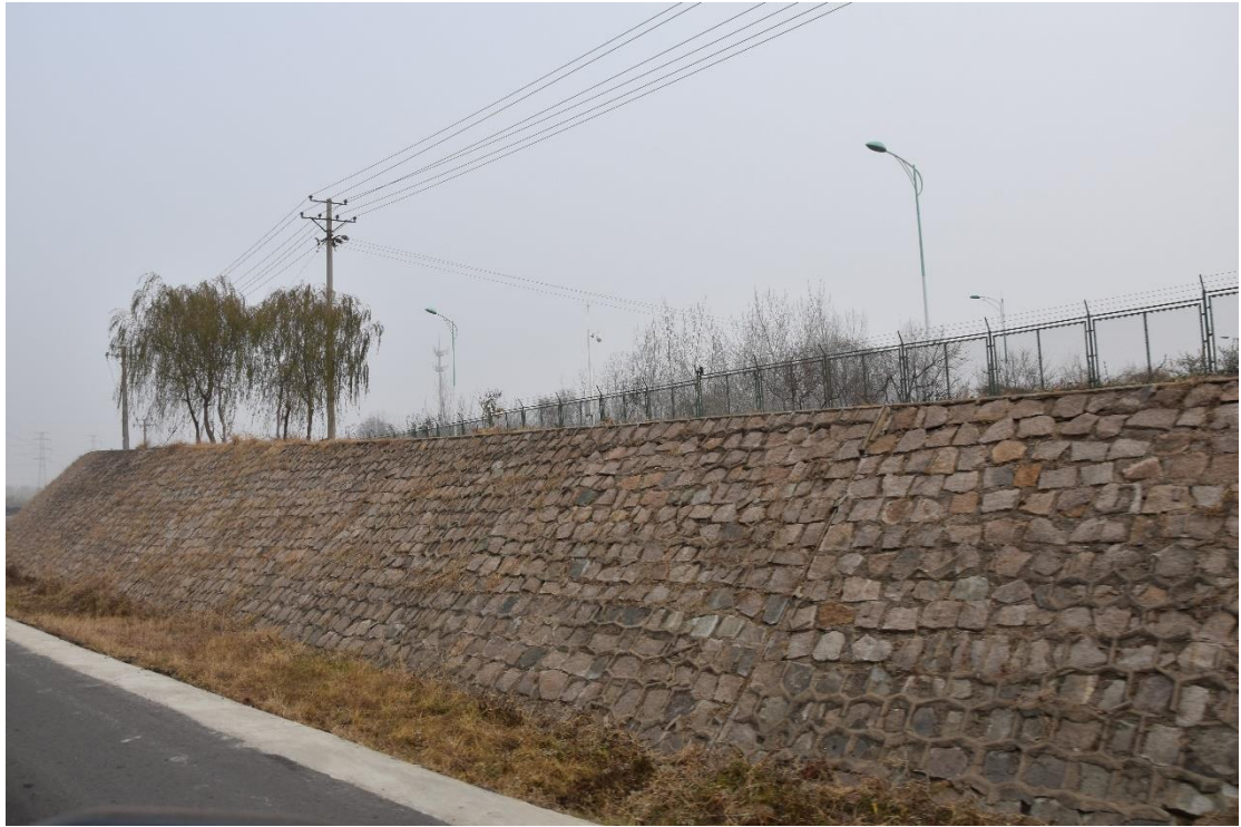
照片 3-2 开发区东区北部防护挡墙
