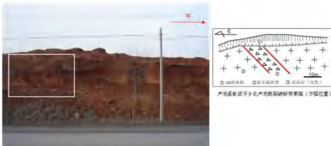
图 1.3.44 卢龙县彭店子乡北卢龙断裂破碎带照片（镜向南）
